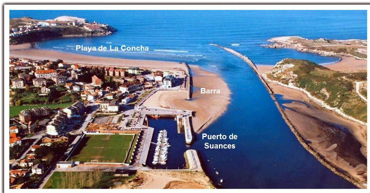
Figura 3. Vista de la ría de San Martín de la Arena durante la bajamar
