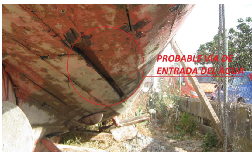
Figura 5. Probable vía de entrada de agua
