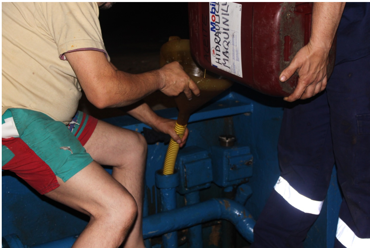
Figura 4. Operación de relleno del tanque hidráulico de la grúa
