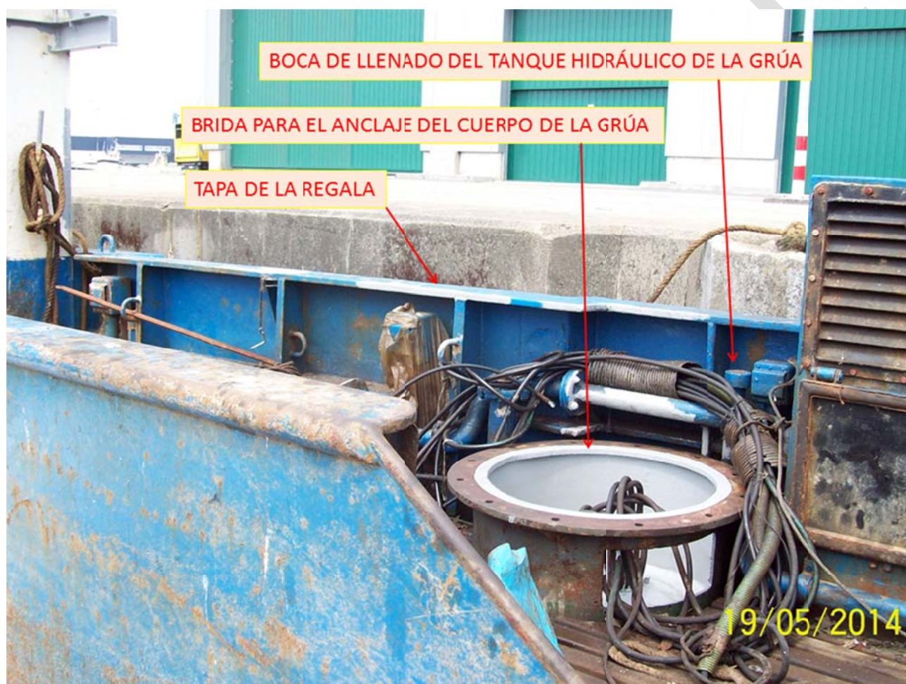
Figura 3. Vista de la zona donde se halla la grúa y la boca de llenado de su tanque hidráulico
